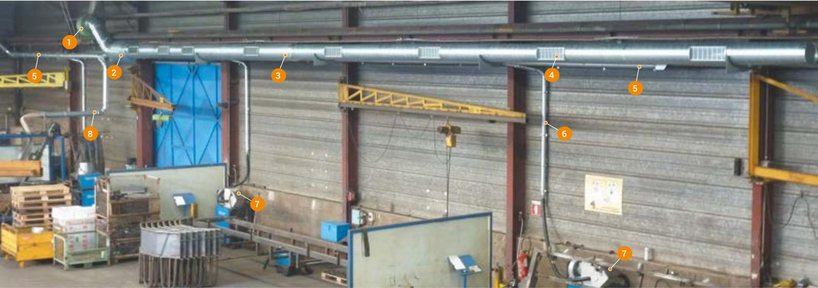
Exemple d'un système de soufflage et d'extraction :
