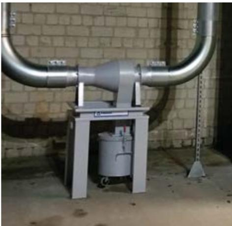
Le pare-étincelle cyclonique permet de retenir toutes les particules « lourdes » avant filtration ainsi que toutes poussières en fusion en créant une chute de vitesse soudaine et un mouvement cyclonique. Il est constitué d'un châssis métallique supportant le cyclone et d'un seau de récupération à roulettes.
