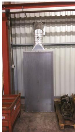
Les plénums d'apport d'air extérieur permettent un apport d'air neuf mécanisé pour compenser un système d'extraction.
