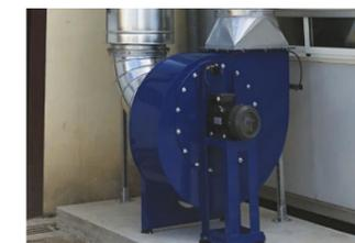
Les moto-ventilateurs employés sont de type centrifuge à pâles renversées permettant spécifiquement l'extraction de flux d'air chargés de poussières.
