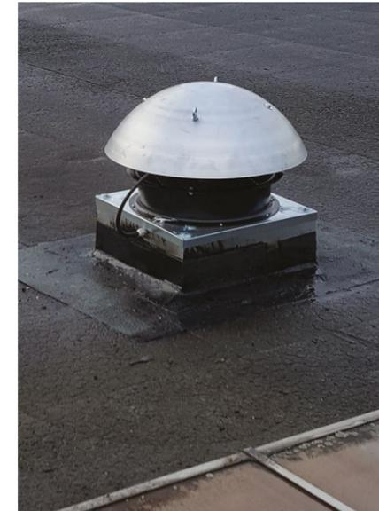
Présentes essentiellement sur le toit des bâtiments et usines, les tourelles de ventilation **ENGMAR** permettent l'insufflation ou l'évacuation d'air et de fumées. Il existe 2 types de tourelles ; les tourelles à jet horizontal TJH possédant un chapeau en tôle aluminium, ainsi que des tourelles à jet vertical TJV en acier galvanisé.
