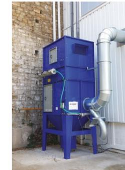
Pour un rejet d'air épuré, des centrales basse dépression **ENGMAR** peuvent être installées. Celles-ci sont dotées d'une préchambre de décantation et sont adaptées aux poussières métalliques. Les poussières décantent dans le caisson d'air sale avant de passer au travers des cartouches dotées d'un média filtrant adapté à l'application. Les installations sont dimensionnées à la demande selon votre besoin. Des filtres certifiés ATEX sont également disponibles.
