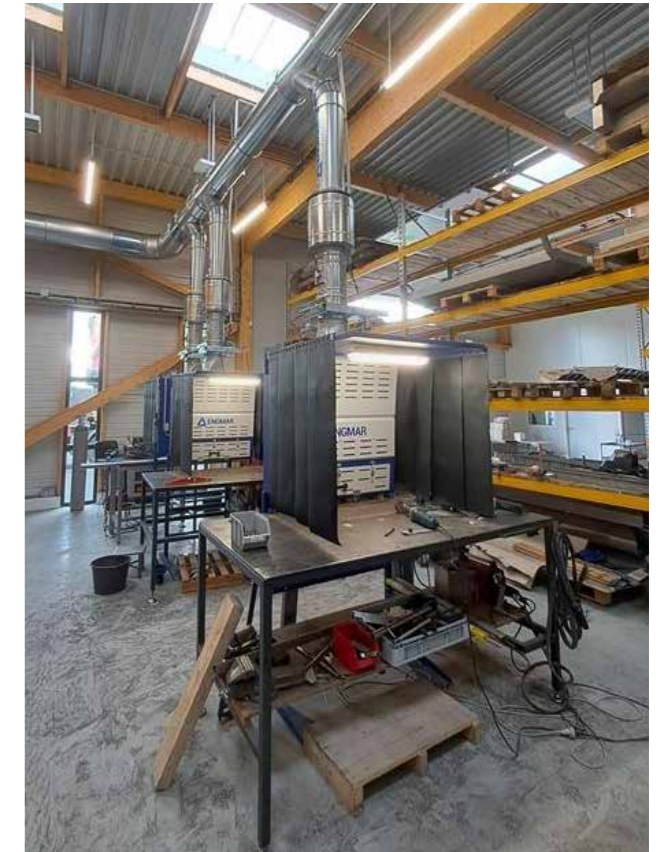
Réseau basse dépression avec dossierets aspirants.
