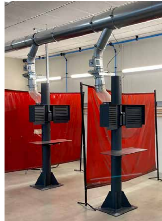
Réseau basse dépression avec mâts aspirants.
