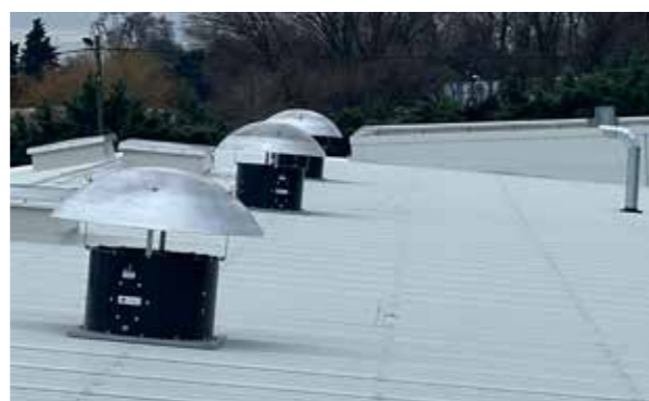
Tourelles avec clapets anti-retour
